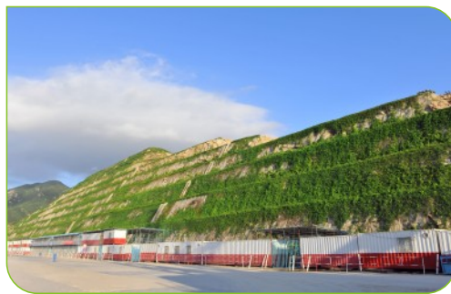
台山核电公司对边坡进行绿化，维护厂址周边良好环境
