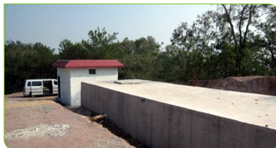
为瑶坑村建设的抽水泵房和蓄水池
